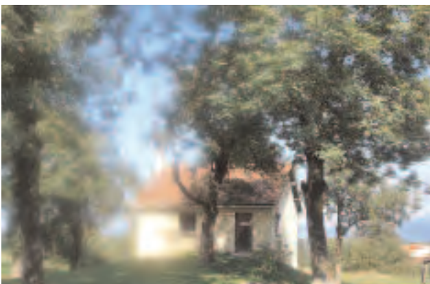
Sanitaires collectifs et bâtiment buanderie
